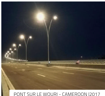
PONT SUR LE WOURI - CAMEROON | 2017
